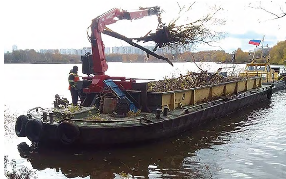
Рисунок 2.36 – Проведение работ по удалению древесного мусора из русла р. Москвы в районе Покровское-Стрешнево
