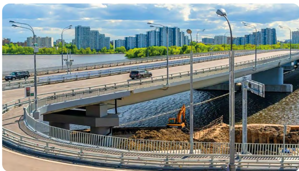
Рисунок 4.41 – Мост через Кожуховский затон
